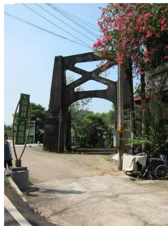
圖 25：月眉橋北岸橋墩 ( 2017 )
