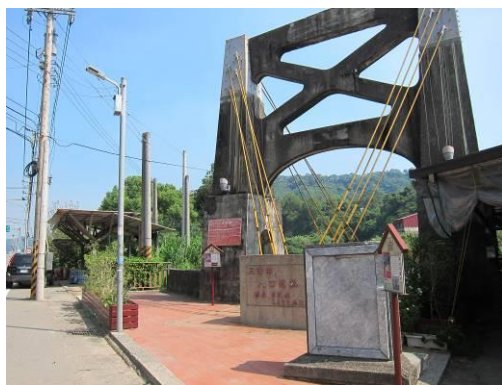
圖 24：月眉橋南岸橋墩 ( 2017 )
